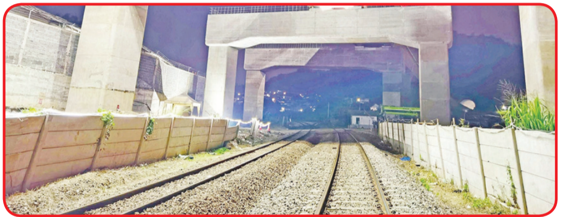
Lokasi konstruksi pemasangan box girder pada 21 Agustus lalu.
