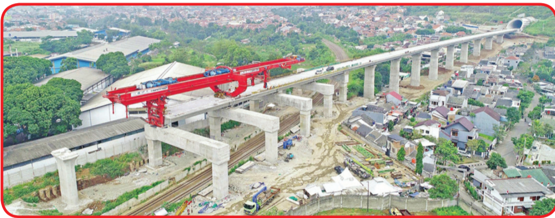
Box girder yang sudah terpasang.
